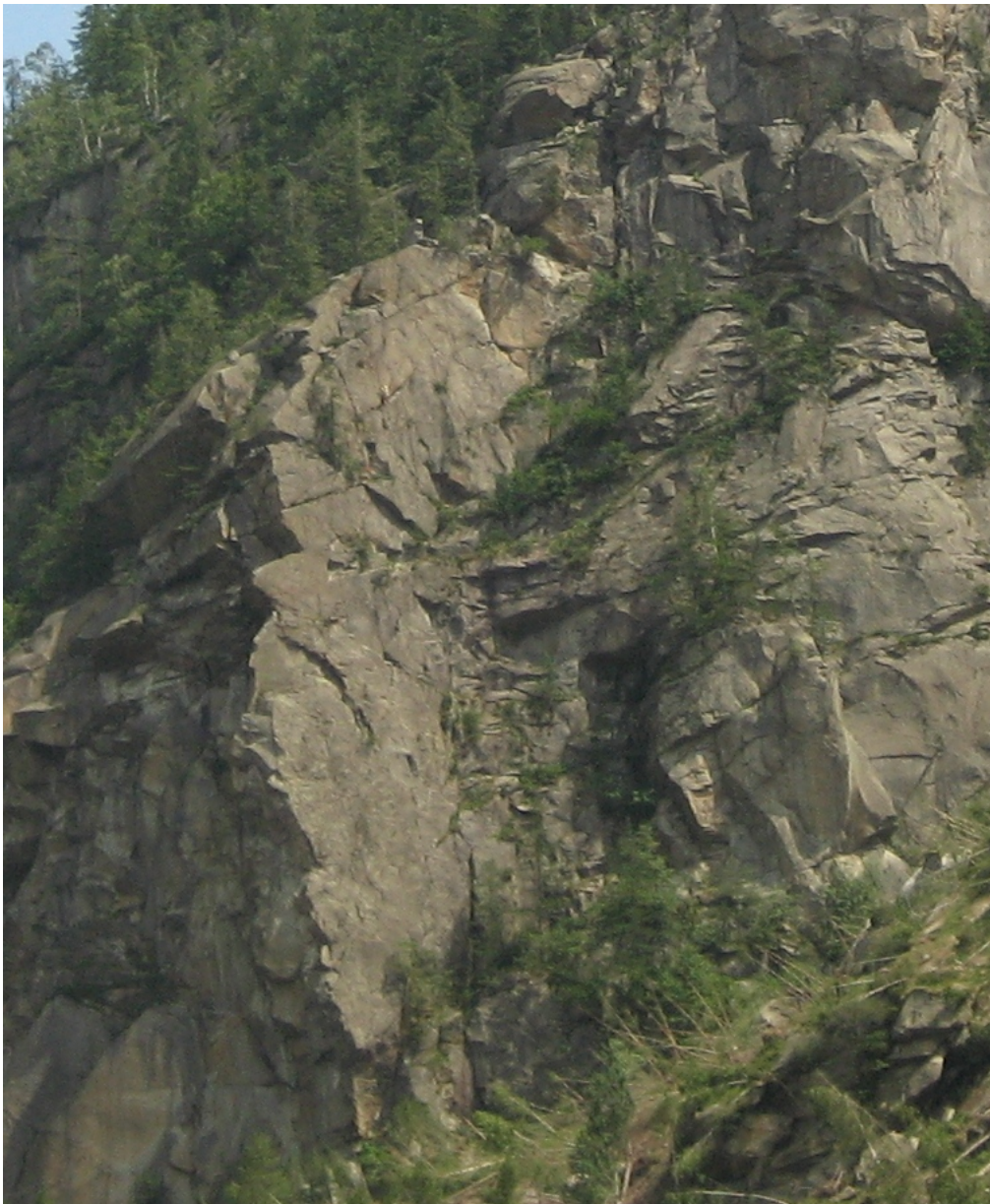
La parete delle Ombre fotografata dalla strada, poco prima dell'imbocco della galleria
